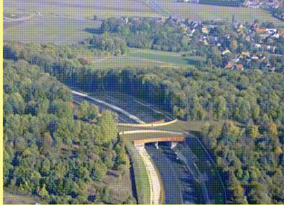
Tranchées couvertes au-dessus d'une section de la RN17 (Source : DREAL Nord – Pas-de-Calais)
