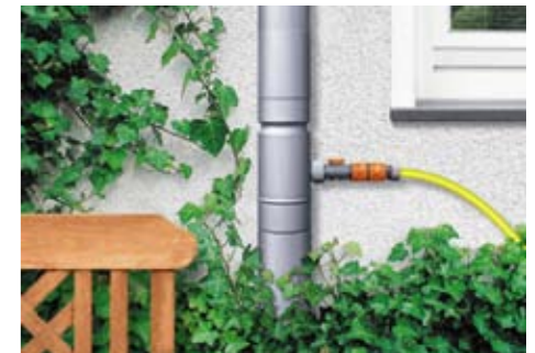
BU: Mit einem intelligenten Dachentwässerungssystem gelangt nur soviel Wasser in die Tonne, wie diese auch tatsächlich fassen kann. Bilder: tdx/www.dach.de
