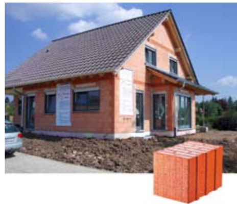
BU: Das europaweit erste nach dem Sentinel-Haus-Konzept zertifizierte Massivhaus entstand in Talheim bei Heilbronn. Als Wandbaustoff wurde der hochwärmedämmende Poroton-T 9 von Wienerberger eingesetzt.
