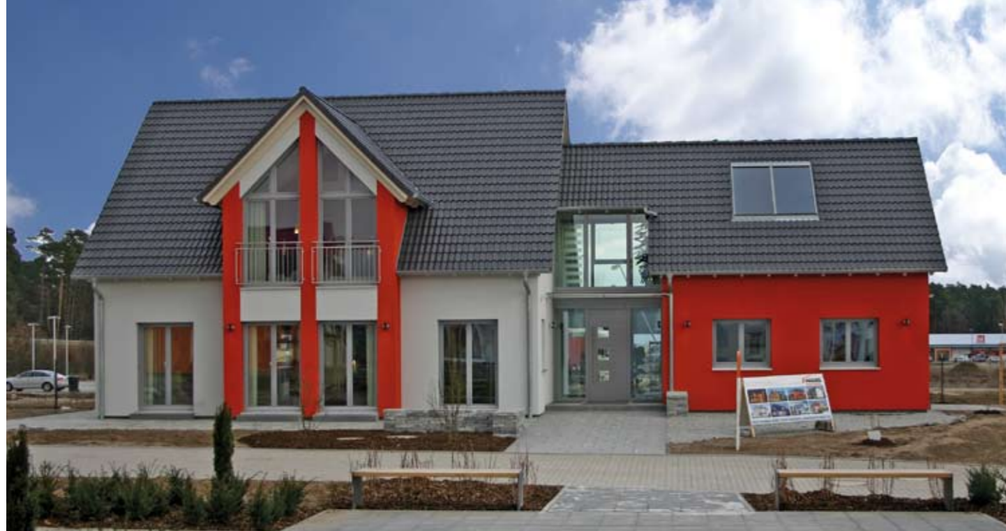
Bild: tdx/Haas Fertigbau
