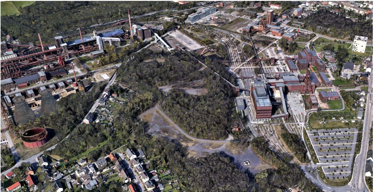
Abb. 1: Zeche Zollverein, Luftaufnahme
