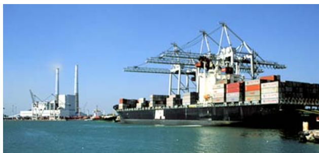
Le Havre (container terminal)
