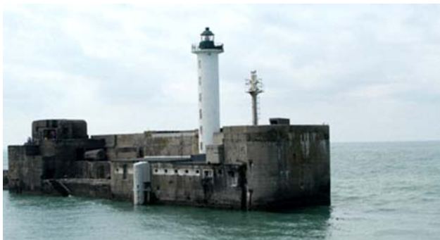
Digue Carnot Light
