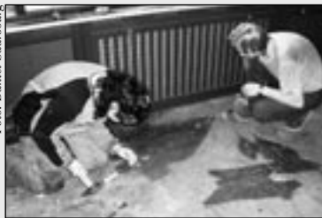
Bevor es einen neuen Fußbodenbelag geben kann muss erst der alte entfernt werden.
