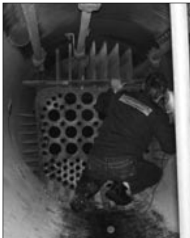
Der Kessel wird gründlich inspiziert.
