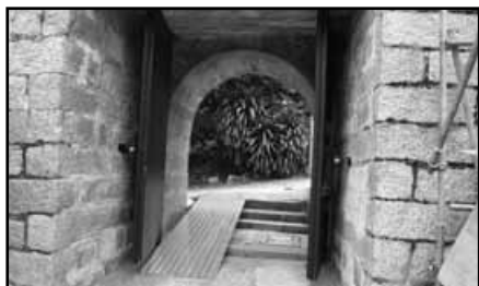
圖1：東涌炮台入口設有斜板
