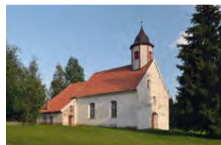
Üsna lihtsa arhitektuuriga Taagepera kirik on põhimahus säilinud originaalkujul.
