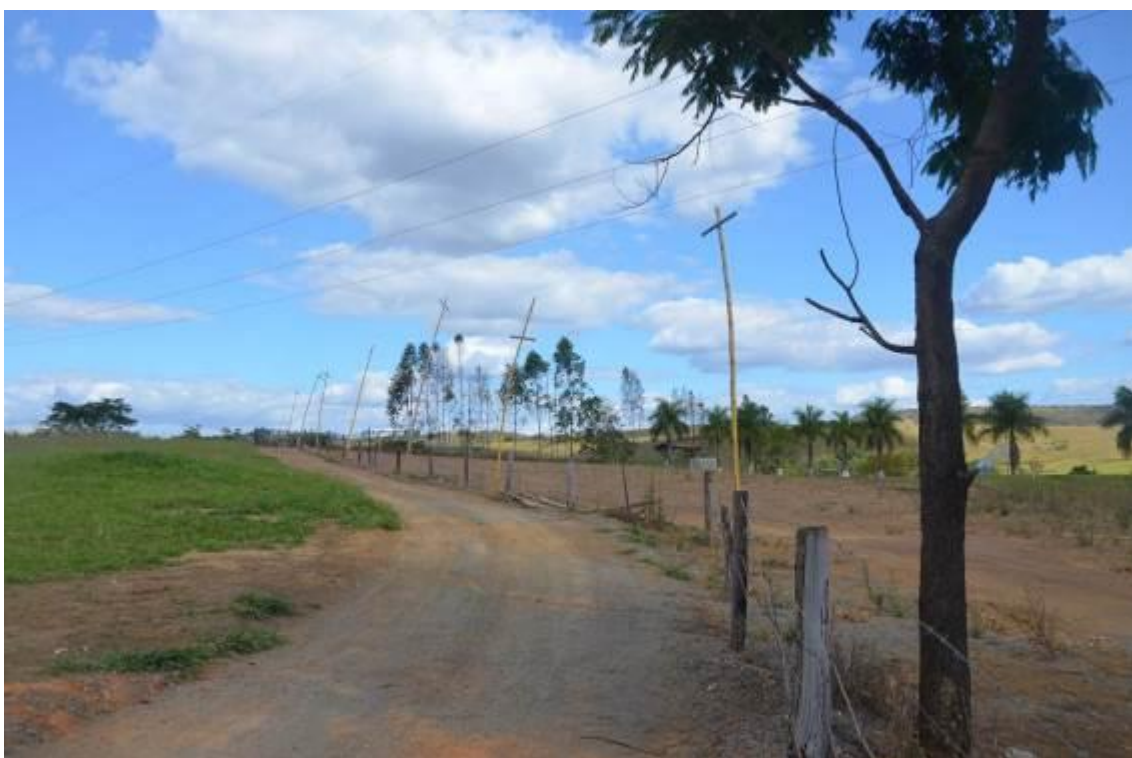
Foto 51. Estrada de acesso ao local da Festa Rave, com posteamento de bambu improvisado para alimentação de energia.
