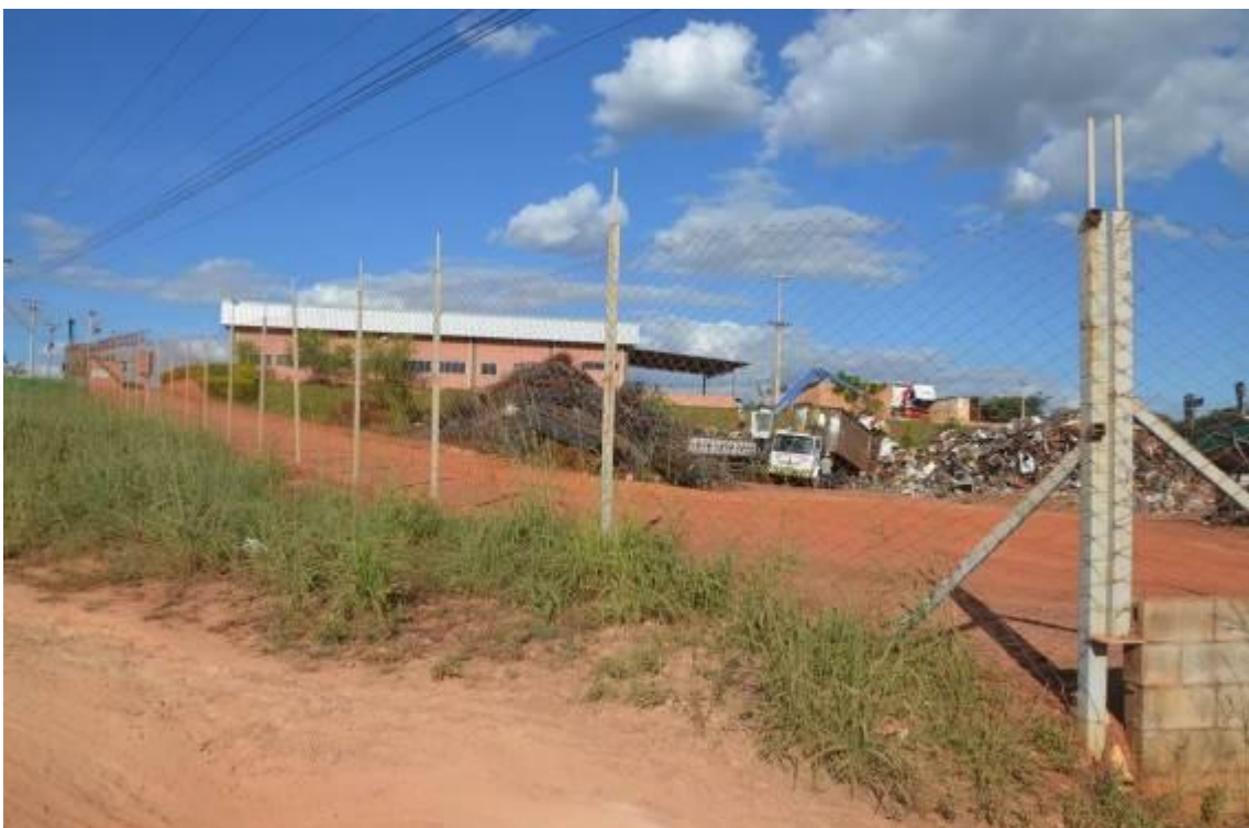
Foto 73. Vista do interior e do galpão do Ferro-Velho, localizado fora da antiga poligonal do Parque.
