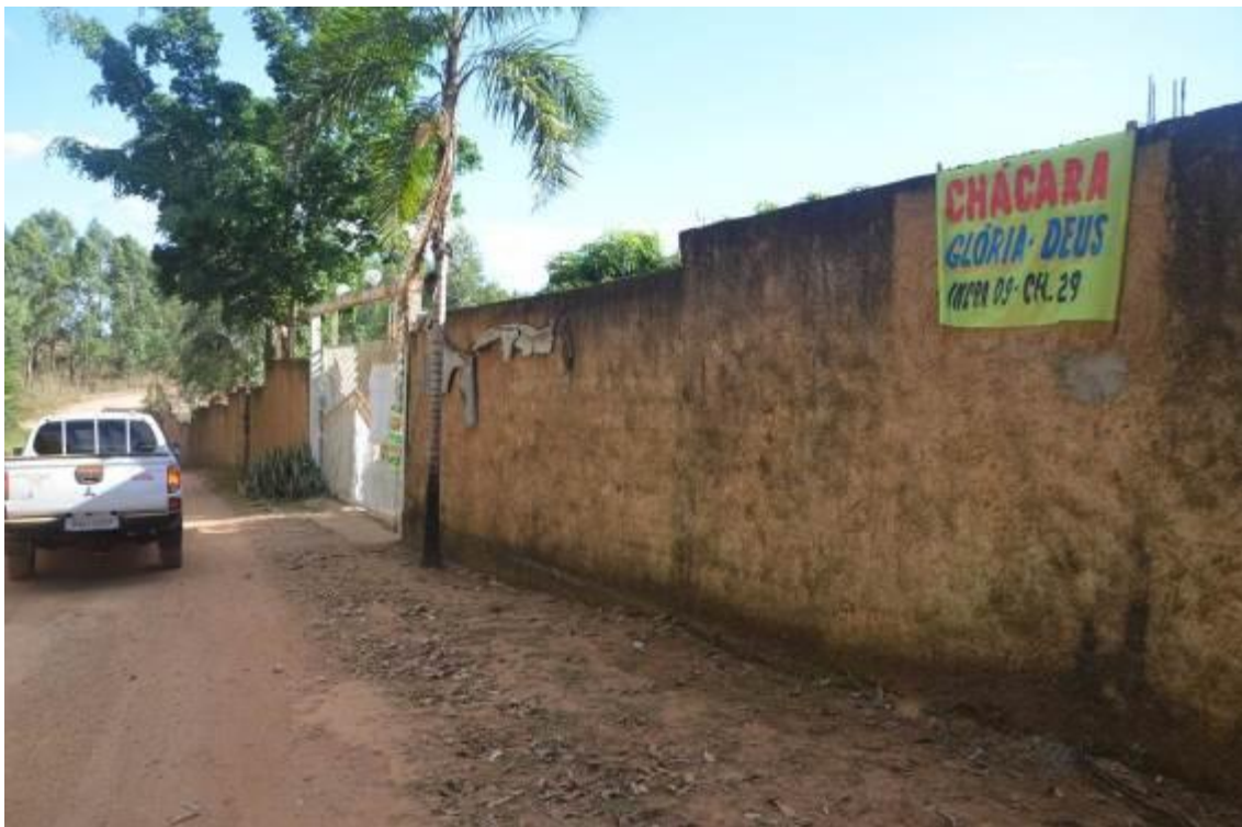
Foto 80. Vista do muro e portão da Chácara Glória Deus, localizada no INCRA 09, chácara 29.
