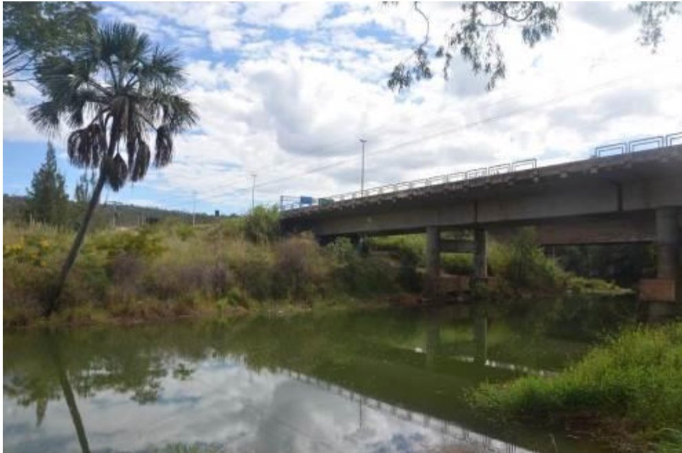
Foto 01. Vista da ponte sobre o Rio Descoberto.
