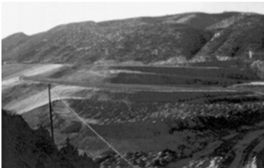
Fot. 10. Vista general del desarrollo del talud.
