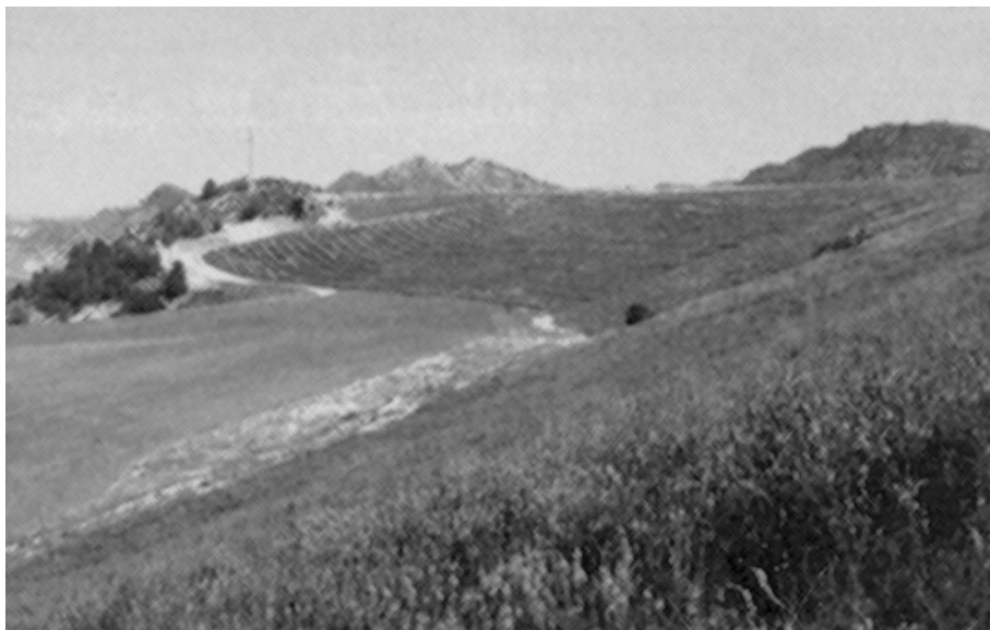
Fot. 4. Vista general de un talud en la escombrera exterior de Corta Barrabasa.
