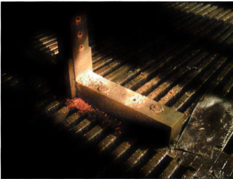
Bild 21: Übersicht über den Probenpunkt: Schwelle und Stiel
