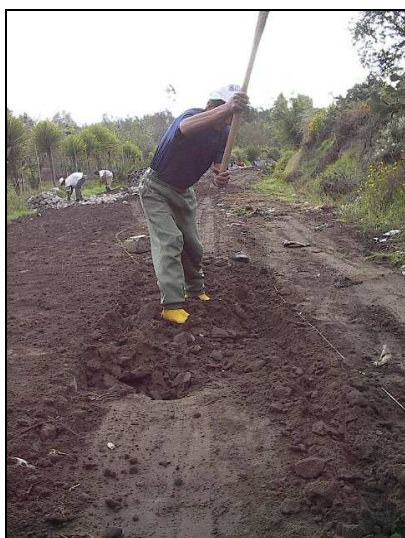
Ilustración 10 – Disgregación de Subrasante
