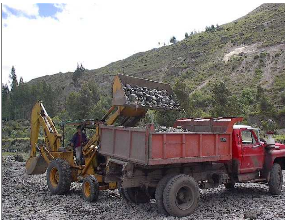
Ilustración 2 - Carga de material a Volqueta
