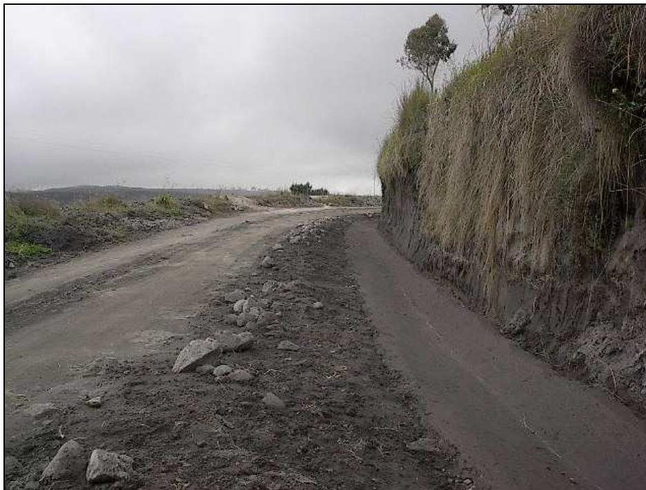
Ilustración 19 – Cuneta Terminada
