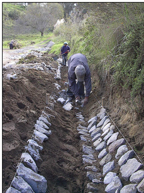
Ilustración 16 – Colocación de Maestras o Cordones Maestros en Cunetas
