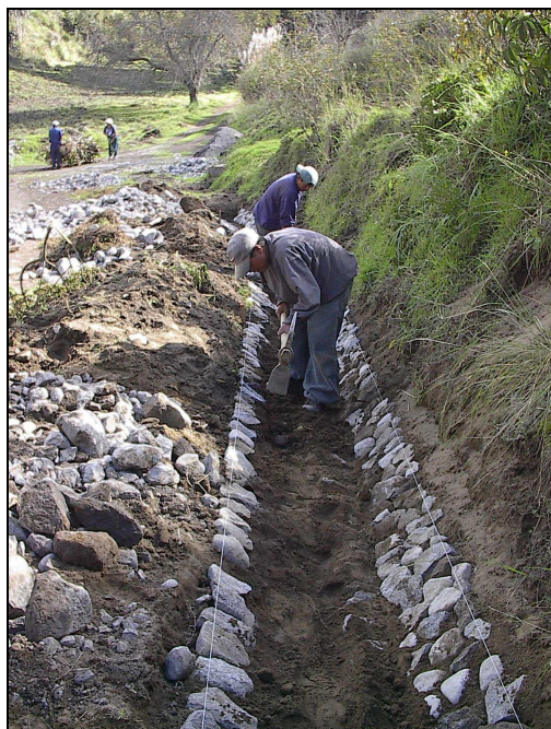
Ilustración 16 – Colocación de Maestras o Cordones Maestros en Cunetas
