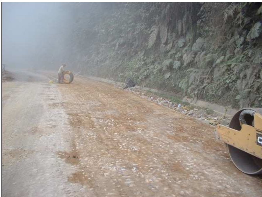
Ilustración 14 – Rodillado del Emporado
