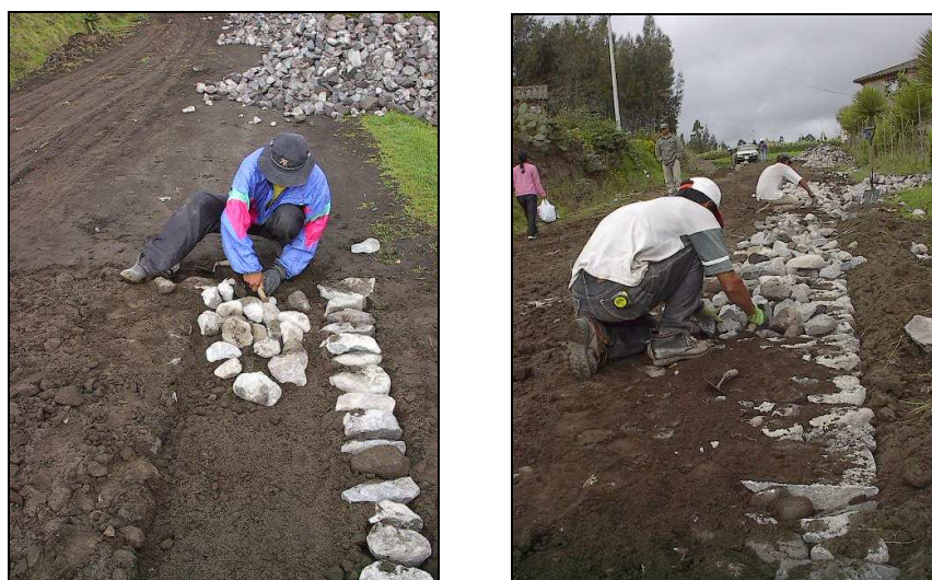
Ilustración 12 – Colocación e Hincado de Piedra en Empedrado
