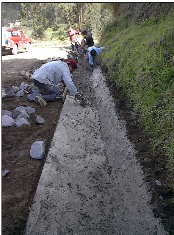
Ilustración 18 – Revestimiento de Cunetas Empedradas
