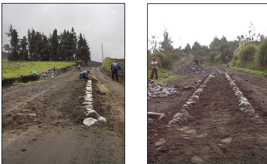
Ilustración 11 – Colocación de Maestras o Cordones maestros
