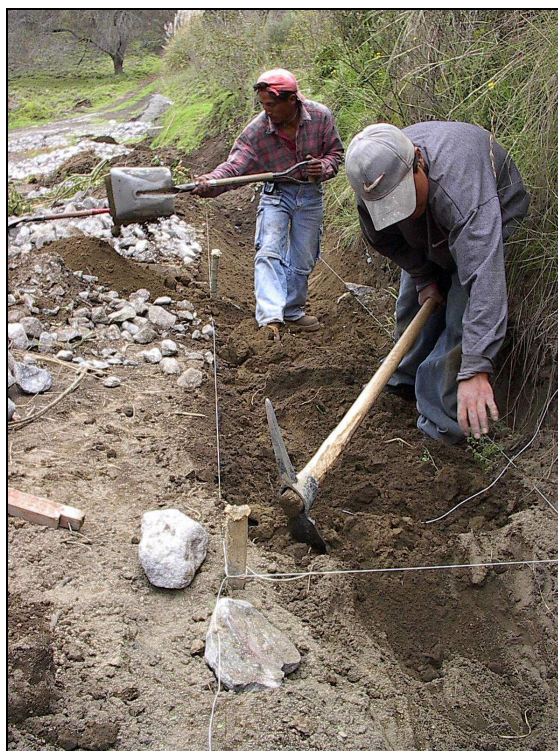
Ilustración 15 – Conformación de la Cuneta
