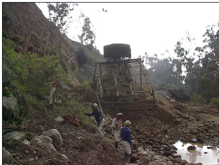
Ilustración 5 – Cribado de material
