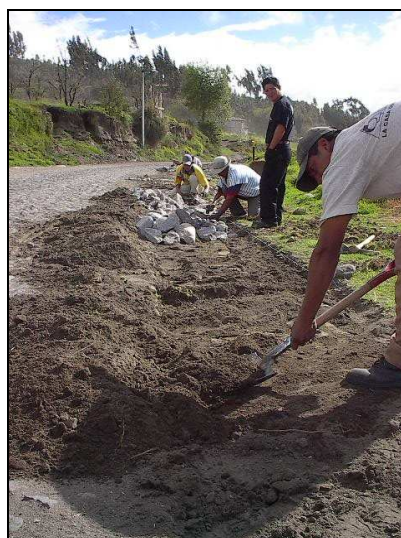
Ilustración 10 – Disgregación de Subrasante
