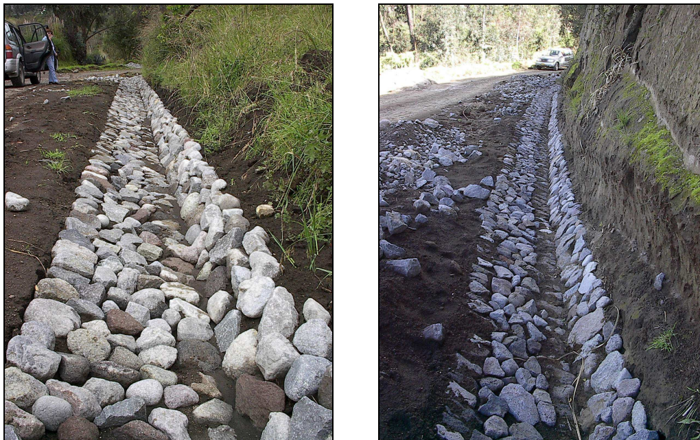
Ilustración 17 – Cunetas empedradas
