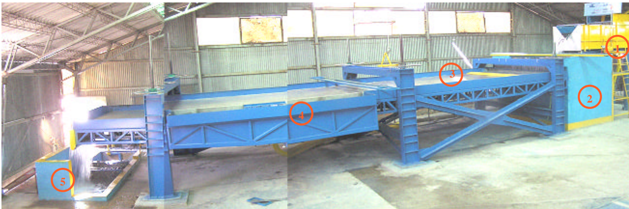
Figura 3-1: Vista General de la plataforma de experimentación de sumideros de aguas lluvias.
