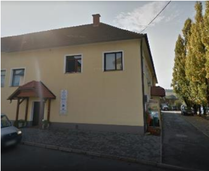
Slika 23: Zgradba Krajevnega urada Šalovci Upravne enote Murska Sobota, Murska Sobota
