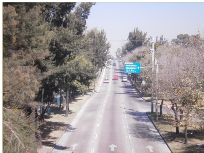
Figura 4.5.1. Avenida Río Churubusco.
