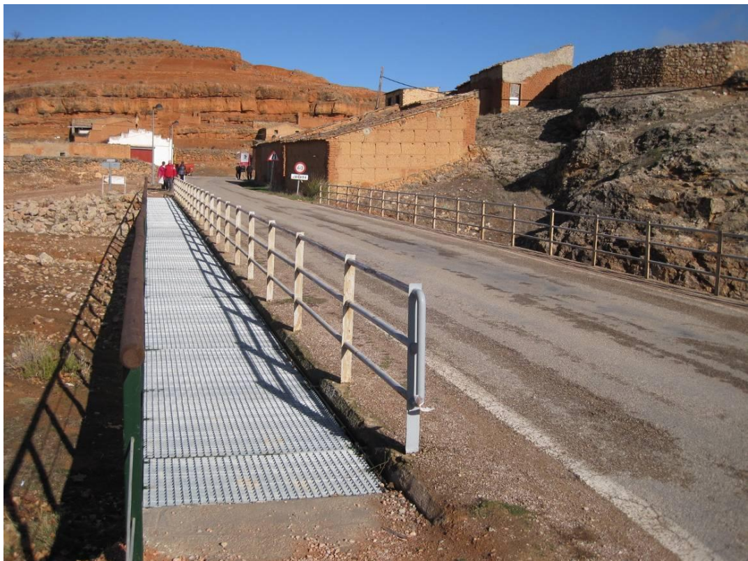
Detalle de pasarela en el puente sobre el barranco de Santa Águeda
