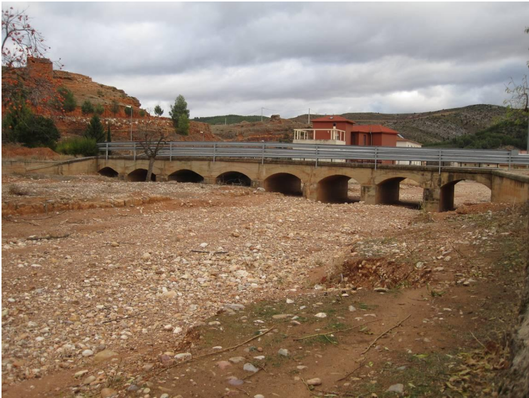
Puente sobre el barranco San Vicente
