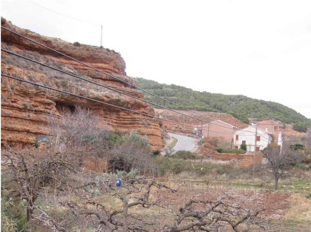
UE-5, zona residencial donde hay que completar las infraestructuras urbanística
