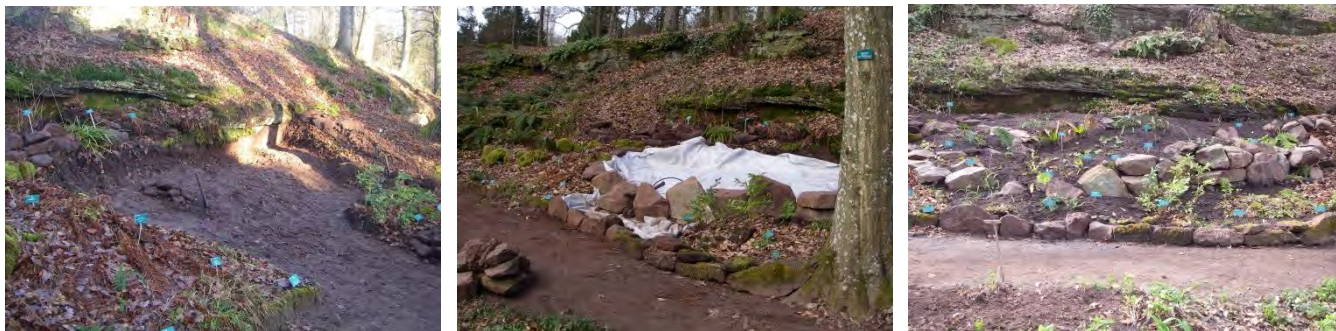
Aménagement de la partie basse de la fougeraie
