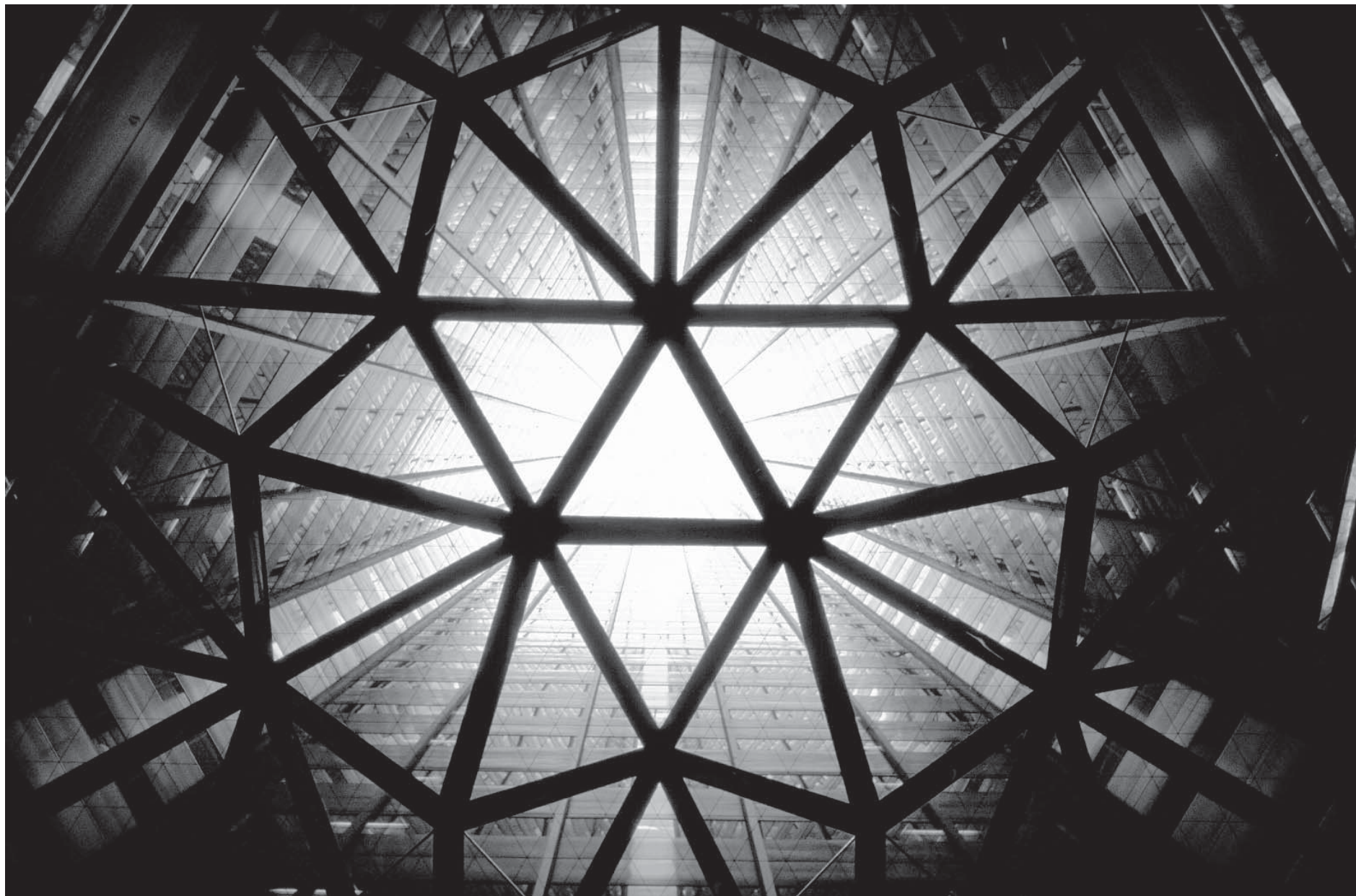
Nikken Sekkei: Shinjuku Sumitomo Building (1974) med dens sekskantede grundplan, her set fra lobbyen og opad gennem den indre bulbed, som er formet af 52 identiske etager. De ialt 176.440 m 2 er overvejende indrettet med kontorlandskaber. På ill. p. 107 ses bygningen yderst tv. i billedet, på ill. p. 103 ses den om natten
