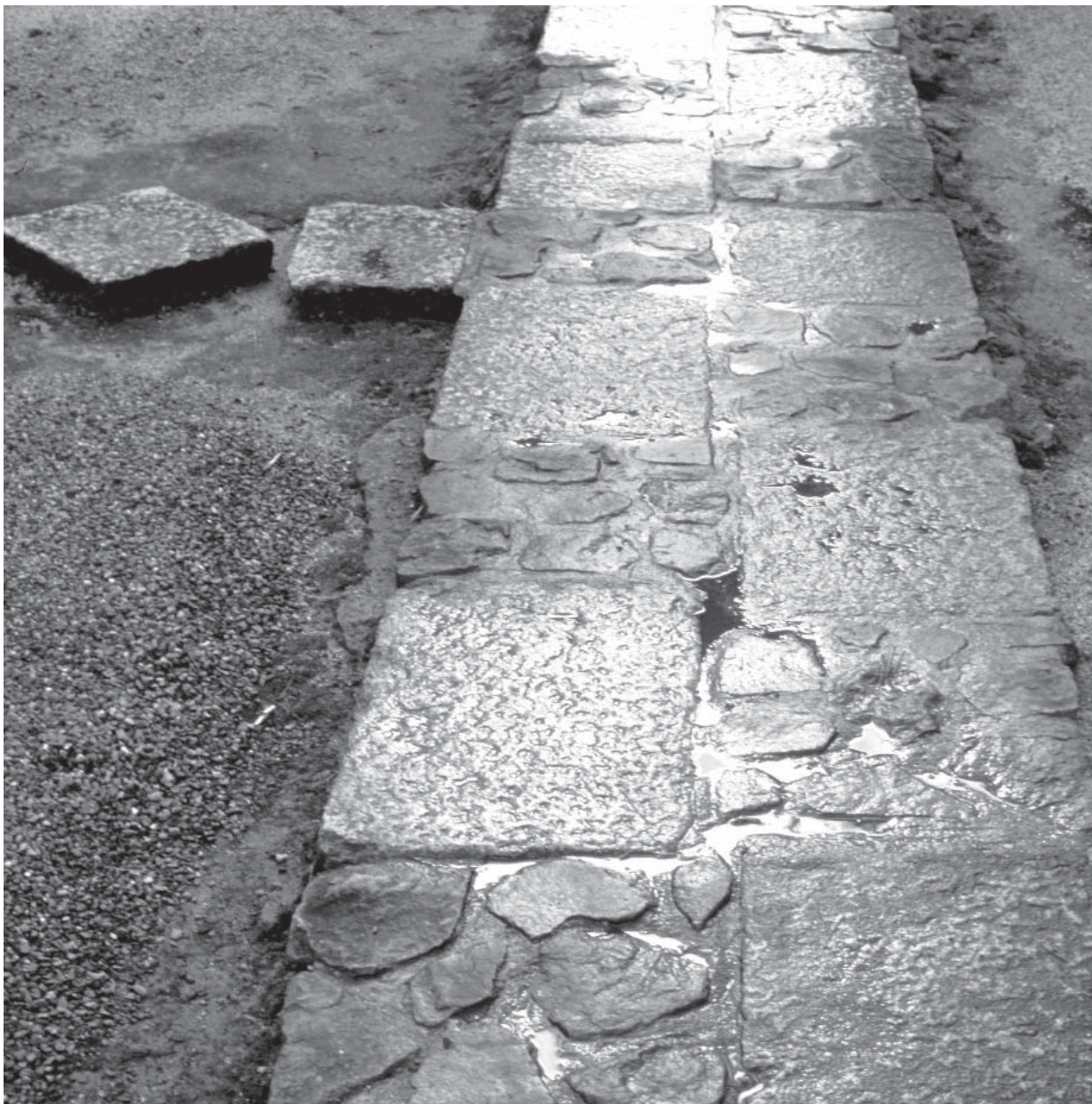
Shin , gyo og so , det formelle, det semiformelle og det uformelle, afspejler sig i templernes belegningsdetaljer. Herover en formel bovedform opbygget af formelle og uformelle dele og kontrasteret af en semiformel sidesti af formelle elementer
