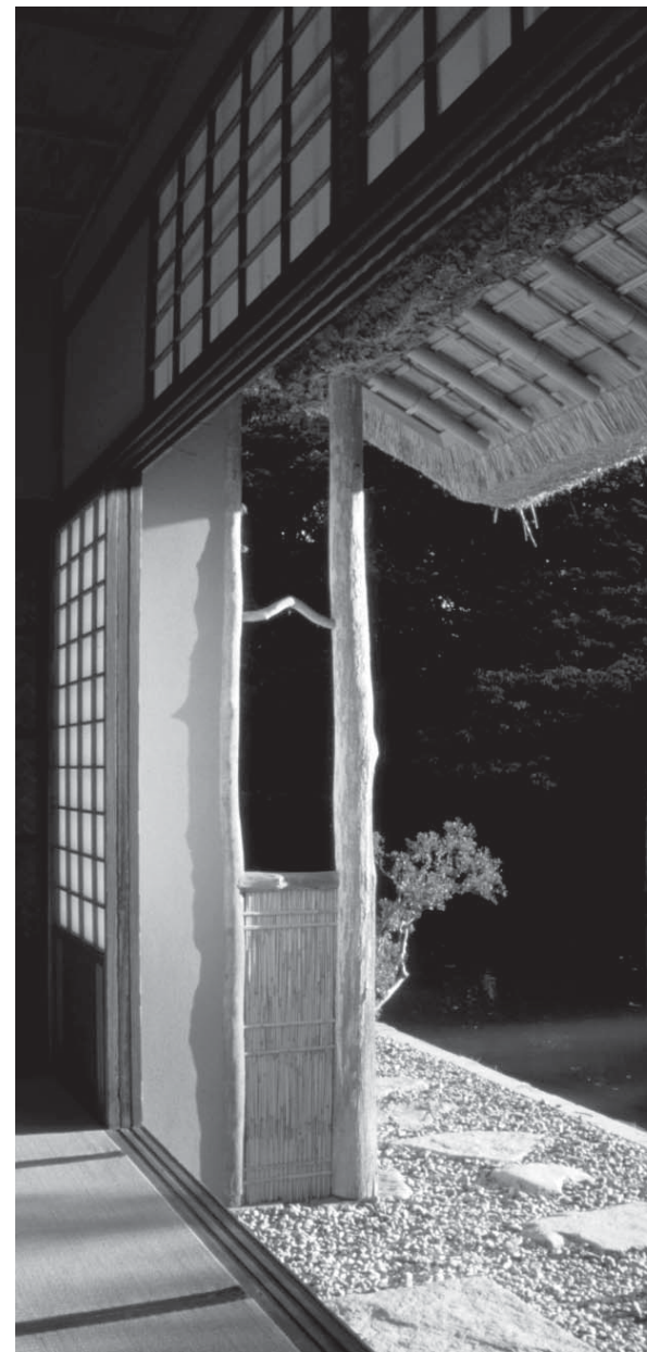
Åbning og udbæng ved Shokin-teis vestgavl, hvor udbængets ås stadig har barken i behold
