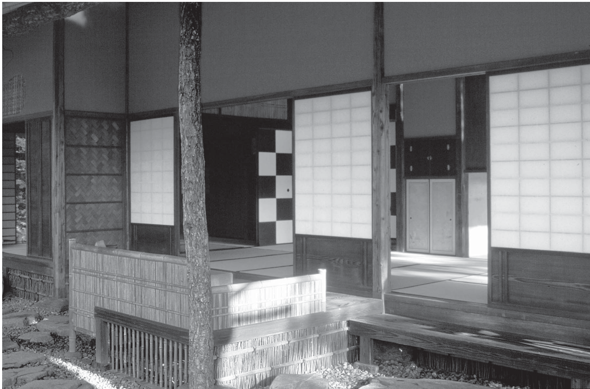
Under det store udbæng ved Shokin-teis langside findes et ildsted, hvor der kan forberedes og serveres te. En række af pavillonens fritstående søjler står med barken i behold
