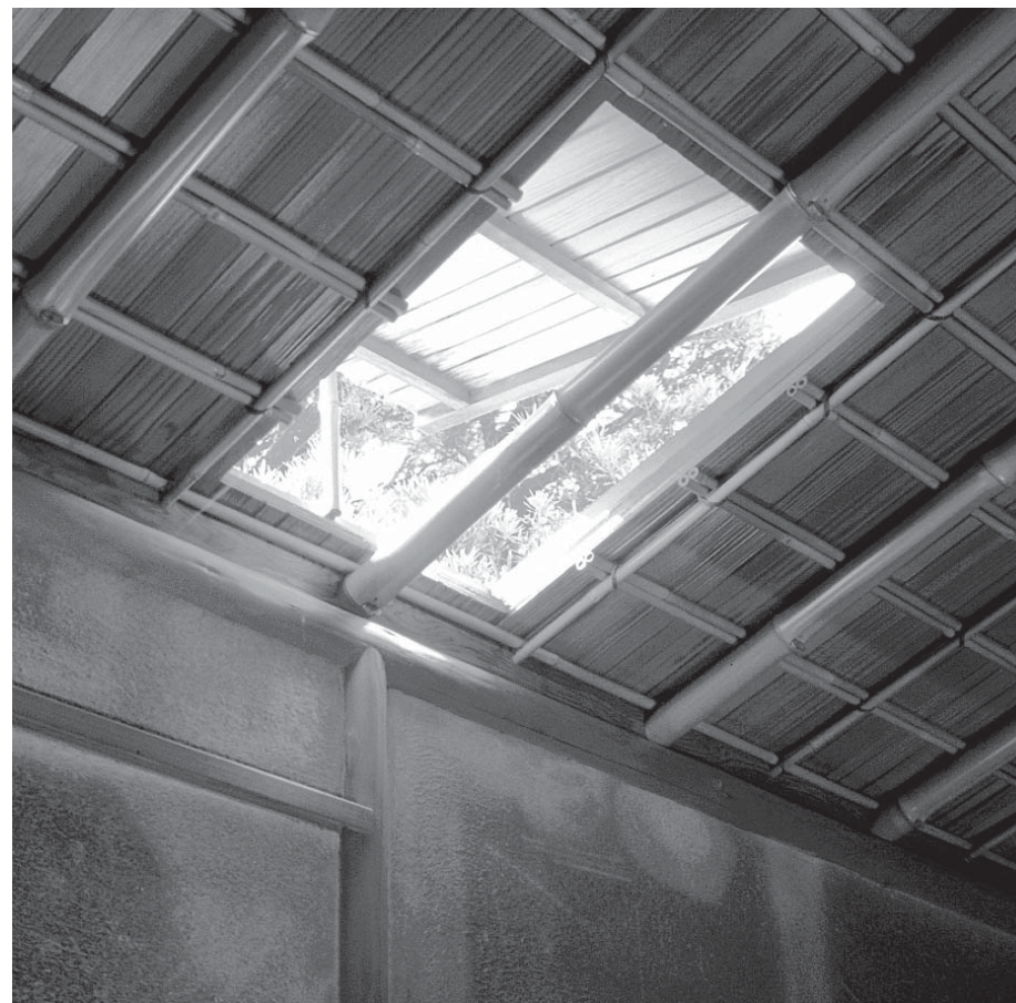
Fushin-an har indbygget et tsukiage-mado , et såkaldt månevindue, i loftet. På billedet står det åbent, men det kan lukkes helt, eller en papirskodde kan trækkes for og diffusere lyset
