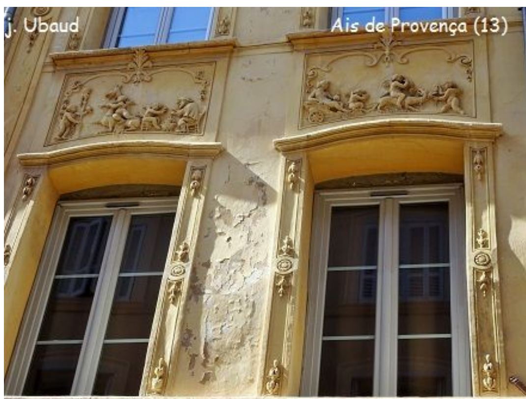
Ostau 18en e gipariás dau gipier Joan Felip Rimbaud – Lo gip veniá dei peirieras de Celòni, pròchas d’Ais.
