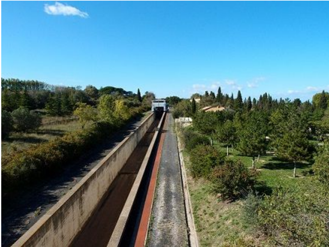
(1) Rampa per far passar las enclusas de Fontserana (Besiers) A jamai foncionat... Son totjorn las vièlhas enclusas de Pau Riquet que fan lo trabalh !
