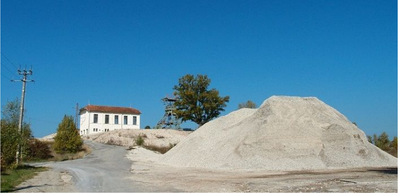
Minas d'asfalte de Sant Joan de Maruejòls (Gard 30) barradas en 2008
