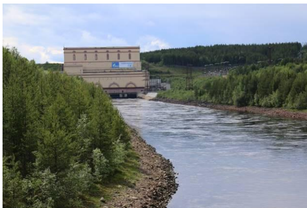
Рис. 73. Канал Княжегубской ГЭС
