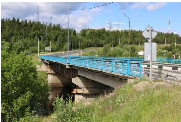
Рис. 75. Мост через канал Княжегубской ГЭС
