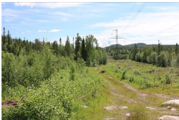
Рис. 84. ЛЭП вдоль а/д Санкт-Петербург-Мурманск и начало лесной дороги к ЮЗ от ООПТ. Фото Н. Поликарповой.
