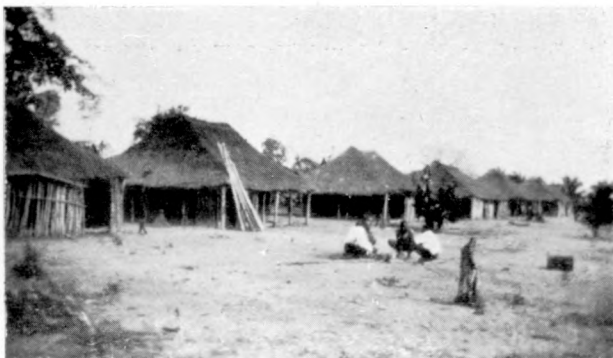
Habitations modernes en pisé, avec véranda. Les maisons sont construites en deux lignes, séparées par une place rectangulaire, « Muwang ».
