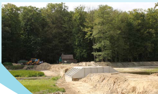
A Kúvölgyi 2. tó töltése felújítás közben
