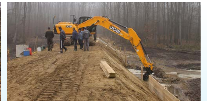
Az új gát építés közben
