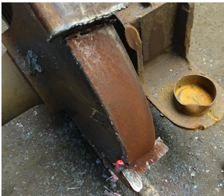
8. ábra: a kerékváz és abroncs rozsdaporos érintkezési s felülete
