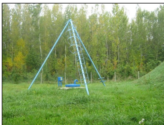
Vízmű - 1.sz. kút /üzemen kívül/
