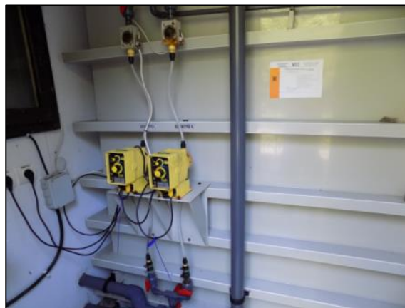
K-V j. vegyszeradagoló szivattyúk
