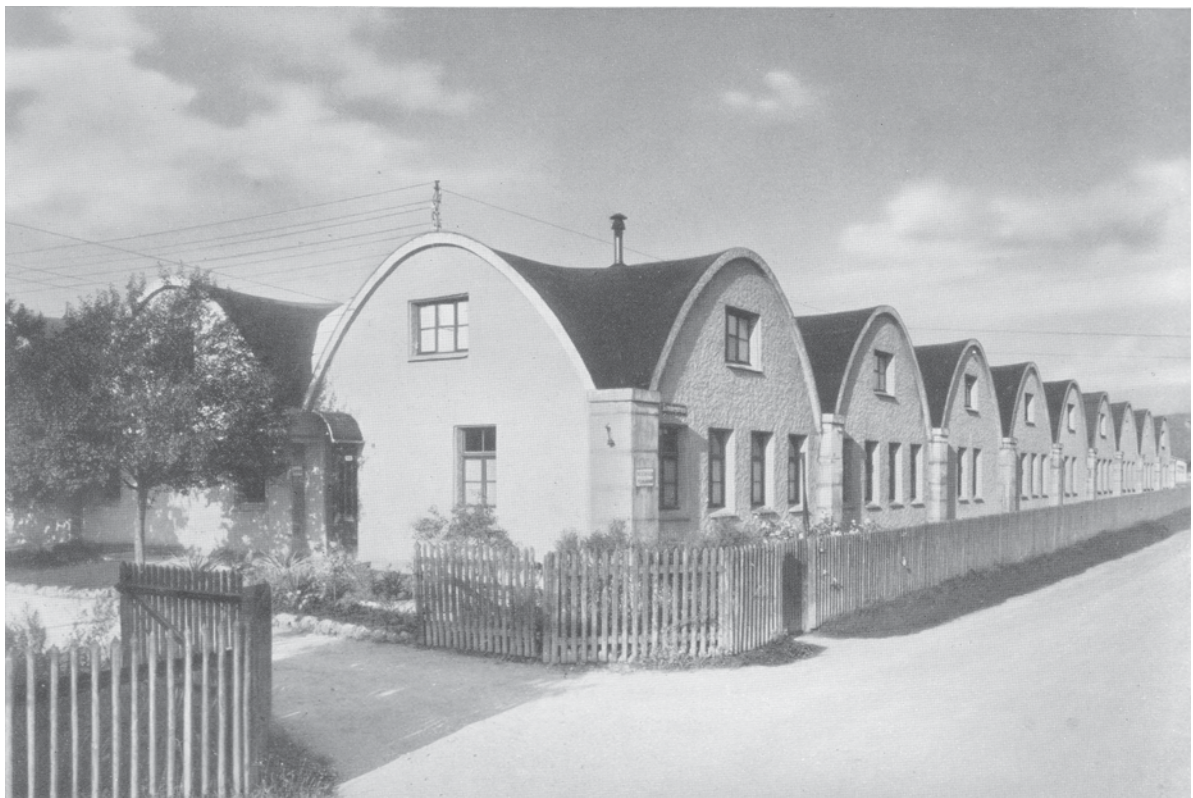
Das Firmengebäude der Haas'schen Schriftgießerei in Münchenstein
