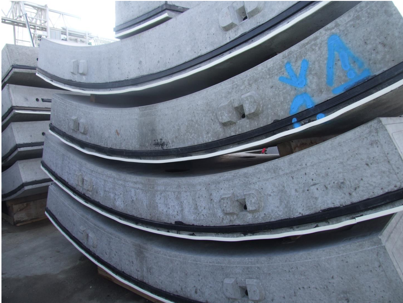
Antigoon spoortunnel LO-RO De eigenlijk boortunnel bestaat uit cirkelvormige beton
