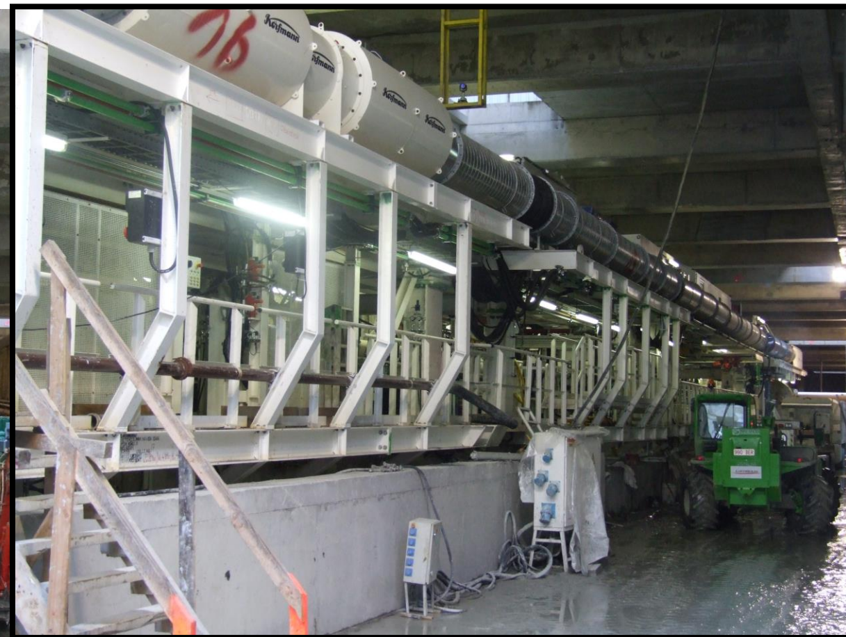
Antigoon spoortunnel LO-RO De boortrein heeft in totaal een lengte van ca 102 m
