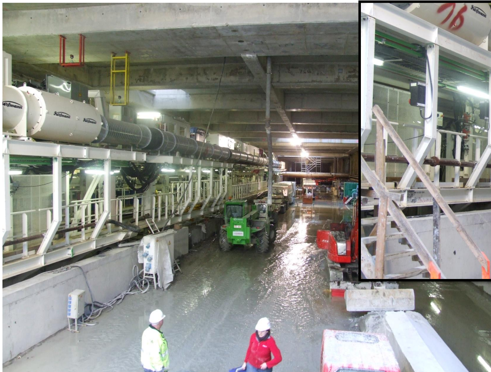
Antigoon spoortunnel LO-RO De boortrein heeft in totaal een lengte van ca 102 m
