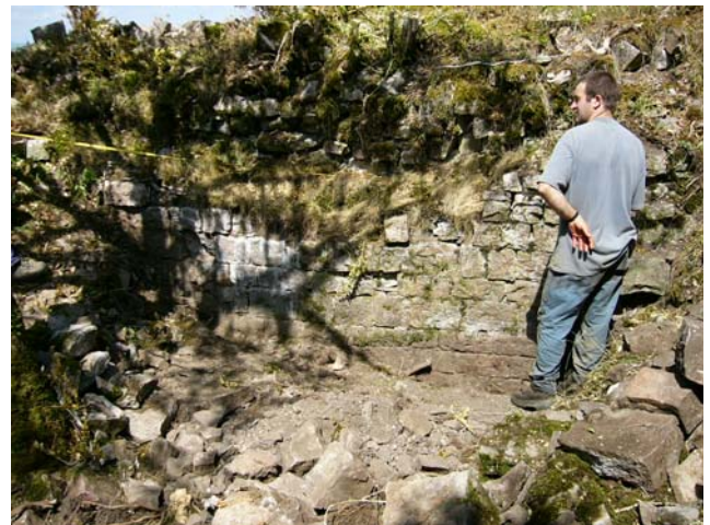
Trabajos de limpieza en las paredes de la fortaleza
