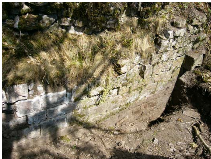
Restos actuales de los cimientos del castillo
