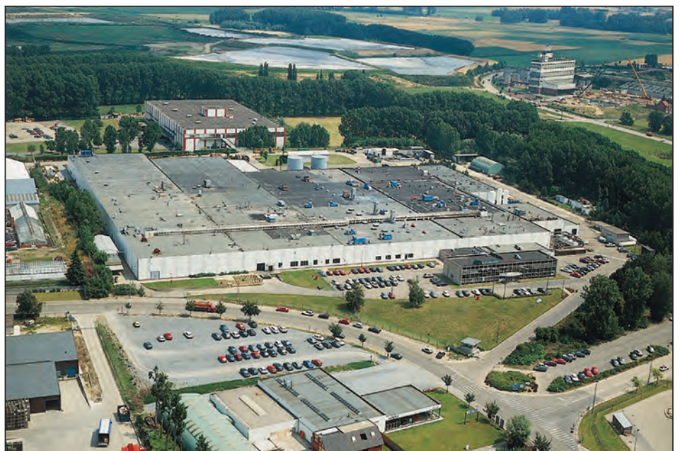
Tienen Factory, Belgium
