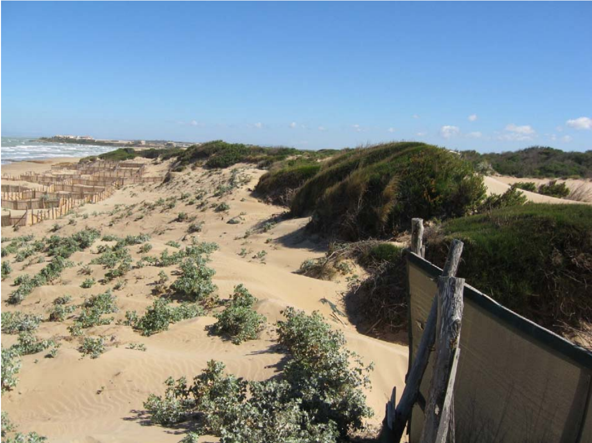
Foto 23 Arretramento della linea di costa di Cammarana
