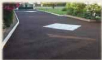
EMULSION GRAVILLONNÉE - PAVAGE ENROBÉ NOIR et ROUGE - DALLAGE
