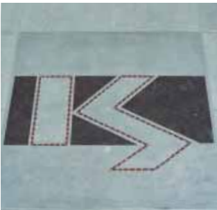
Einbau in Fußboden
