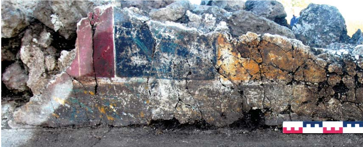
fig. 2 - Bâtiment V, bas de paroi conservé en place contre le mur [26027-3].
