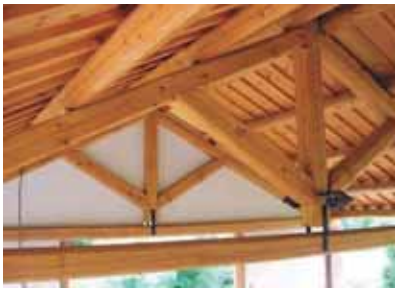
Es. Struttura portante dei tetti in legno
