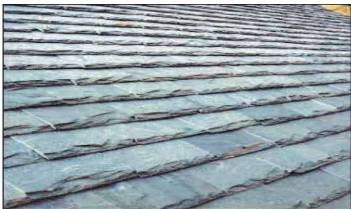
Es. Copertura in Ardesia
