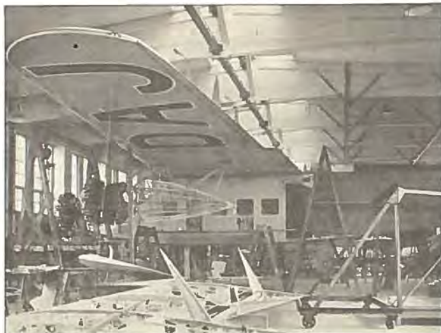
1 / 4 — Monteringsarbejdet er i fuld Gang.
