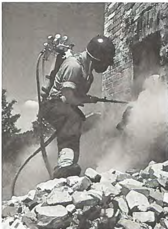
Det mest moderne materiel anvendes under redningsarbejdet.
