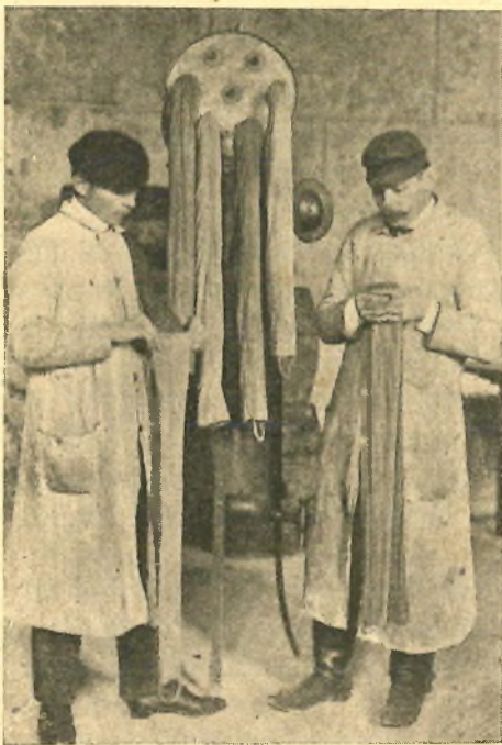
57. ábra. A hollandi szűrő zsákjainak összehajtása s egymásbahelyezése.
