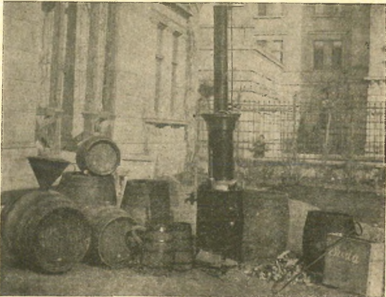
2. ábra. A Bourdil-féle gyorsforraló, hordók forrázásához használva.
