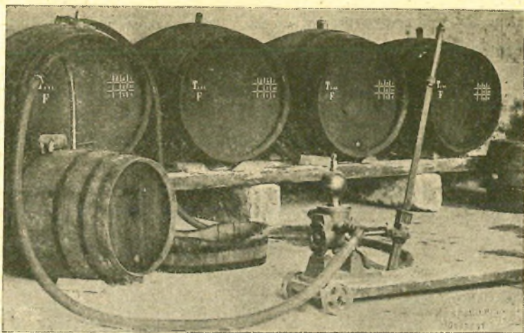
50. ábra. Közös dugattyús fejtógép csővezetékekkel, szívópipával felszerelve.
