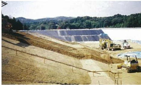
図 2.5.10 ベントナイト混合土の施工風景(静岡県浜北市)
