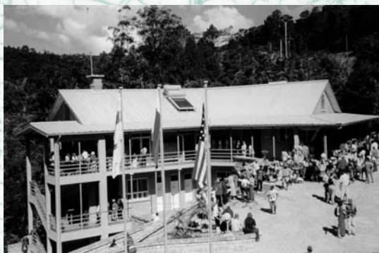
Centre ValBio at Ranomafana Centre ValBio à Ranomafana
