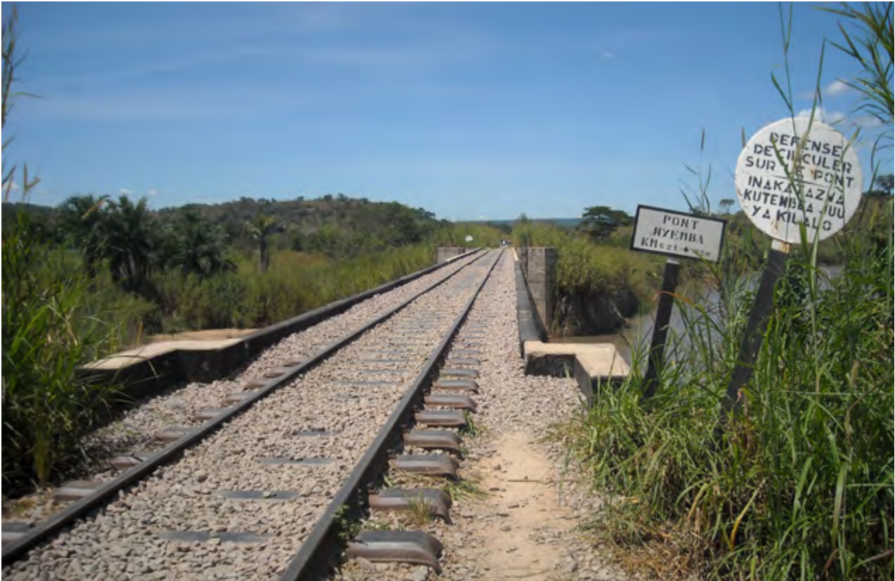
Pont Nyemba après réhabilitation.
