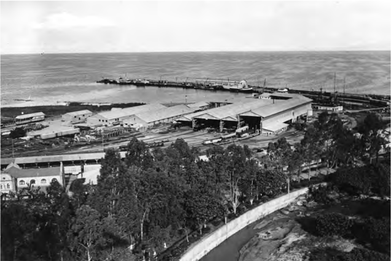
Vue aérienne du port d'Albertville, montrant la gare, les ateliers et le port, 1951. (HP1956.15.3204, collection MRAC Tervuren; photo C. Lamote [Congopresse], 1951, © MRAC Tervuren.)
