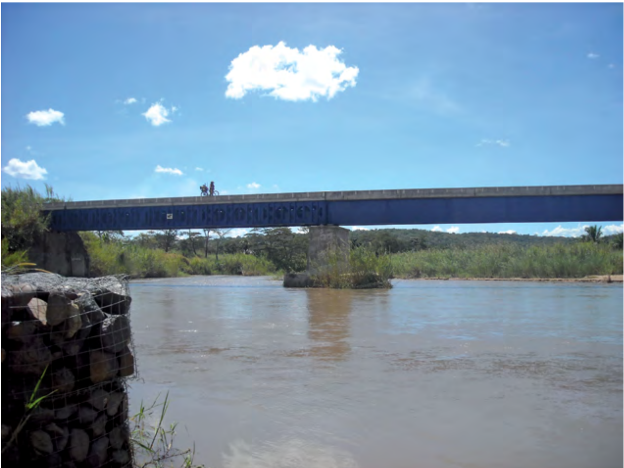
Vue sur le pont Nyemba. (Photo équipe locale, 2009.)
