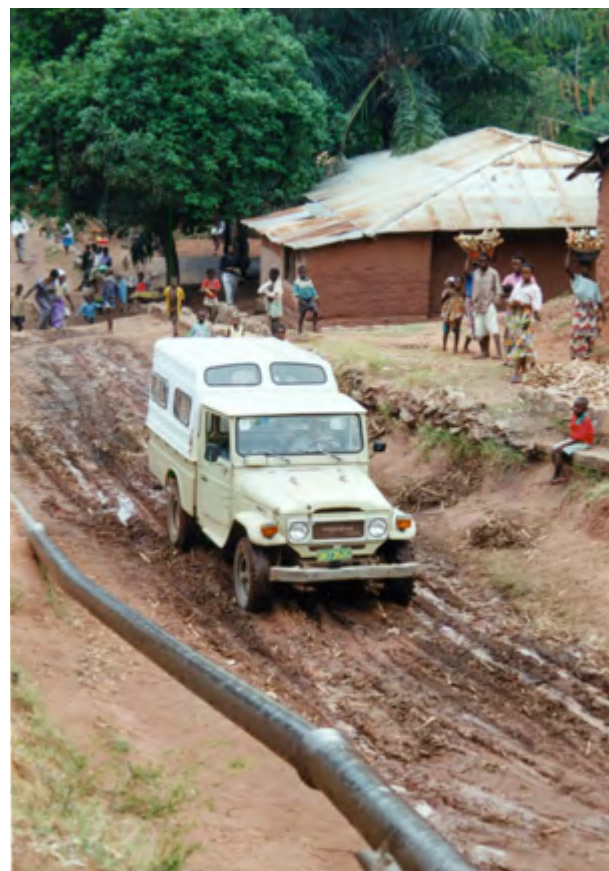
État d'une route locale.
