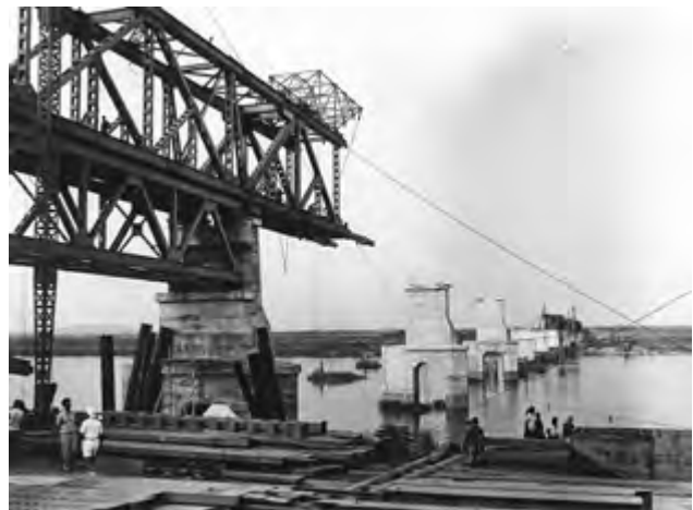
Pont de Zofu (795 m) sur la jonction Kabalo-Kamina, en construction. (HP.1956.22.79, collection MRAC Tervuren; photo C. Lamote [Inforcongo], © MRAC Tervuren.)
