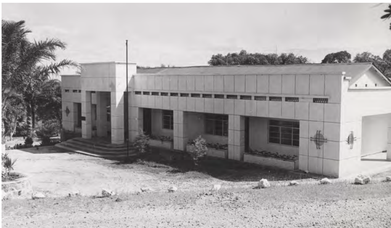
Les bureaux du district, à Albertville.
