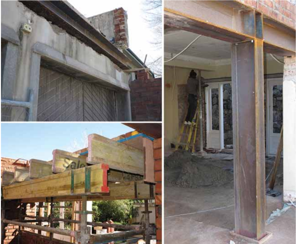
Figuur 25: I-balke van staal word dikwels in geboue gebruik. I-balke van hout word dikwels gedurende die bouproses van 'n gebou gebruik, maar word verwyder sodra die gebou sy eie gewig kan dra.
