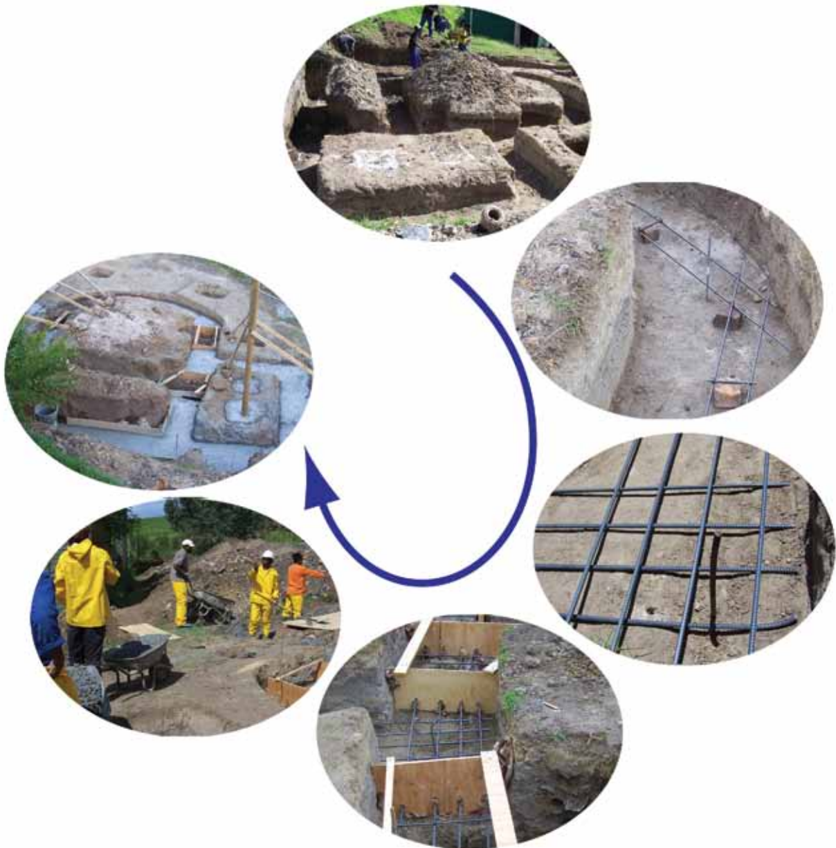
Figuur 18: staalstawe word gebruik om die betonfondamente van 'n nuwe huis te versterk.
