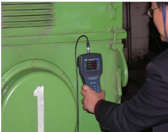
HV Motor PD Testing – TEV & CT
