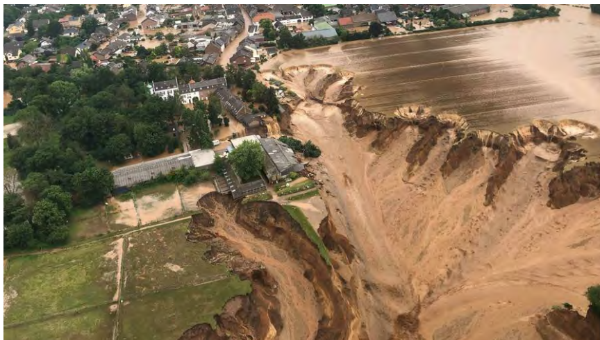
Abbildung 2: Überschwemmung in Erfstadt-Blessem im August 2021 (Foto: dpa)
