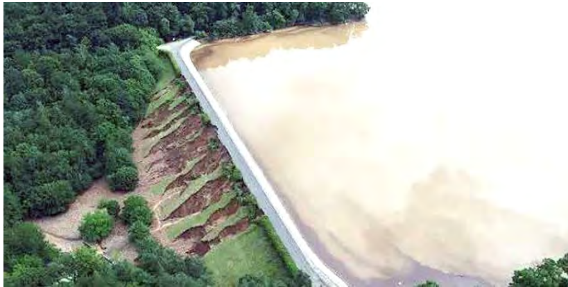
Abbildung 1: Damm der Steinbachtalsperre (Foto: Feuerwehr St. Augustin/Rhein-Sieg-Kreis, Janczura, S. (2021))
