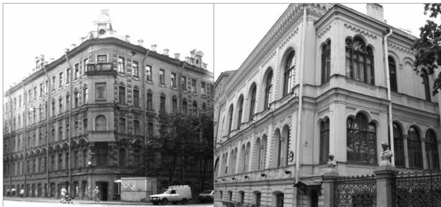
Фото 2. Здания на Английском проспекте (слева) и Конногвардейском бульваре (дворец Кочубея) в которых последовательно размещалась лаборатория А. А. Ячевского.
