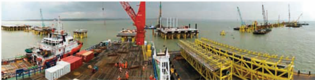
LNG Regasification Project, Malacca
