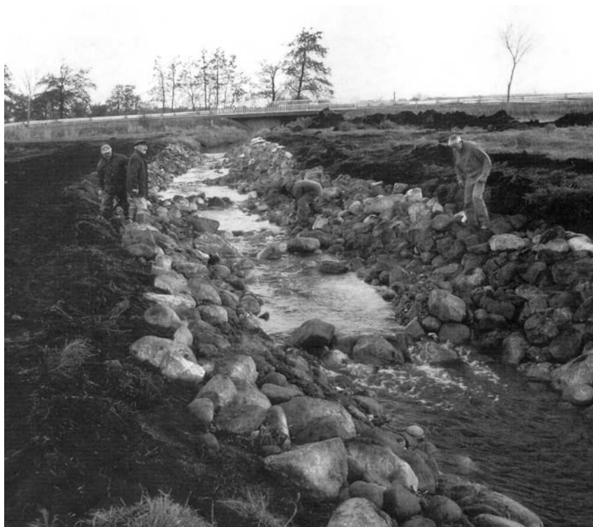
Abb. 4. Das Wasser strömt über die fertiggestellte Sohlgleite
