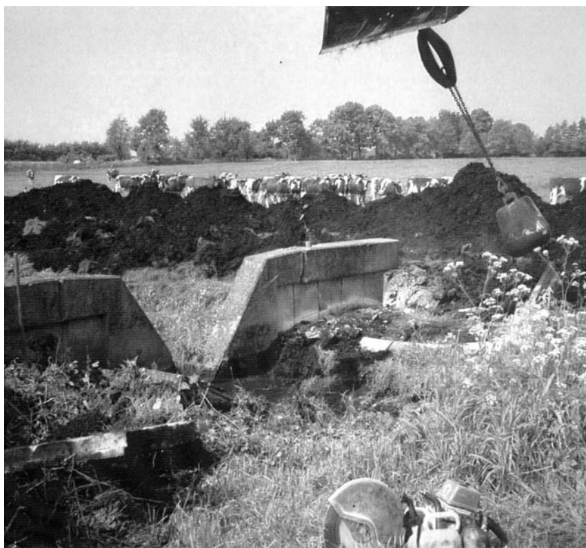
Abb. 3. Abrissbirne beseitigt Sohlabsturz
