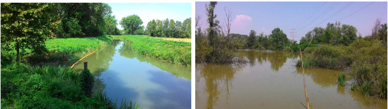
Fig 3 - A sinistra il punto di immissione dell'acqua dal fiume Marzenego nel bacino di fitodepurazione, a destra l'ecosistema filtro e i tralicci di Terna che attraversano l'area protetta. L'acqua del fiume Marzenego entra nel bacino e per gravità defluisce attraverso l'area umida impiegando 6 giorni prima di immettersi nel Rio Roviego; il passaggio attraverso l'ecosistema filtro consente un notevole abbattimento del carico inquinante di azoto totale (TN) e fosforo totale (TP) che andrebbero sversati nella Laguna di Venezia.
