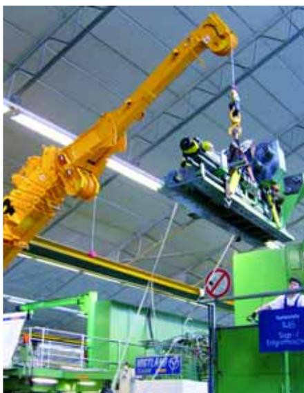
**Einsatz der Firma Wiesbauer aus Bietigheim-Bissingen:** Austausch von einem Motor in einer Industrieanlage.
