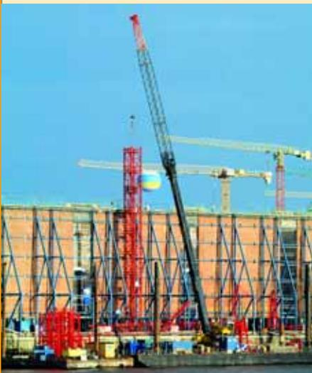
**Anspruchsvoll:** Montagearbeiten durch einen Liebherr LTM 1500-8.1 auf einem Schwimmponton.
