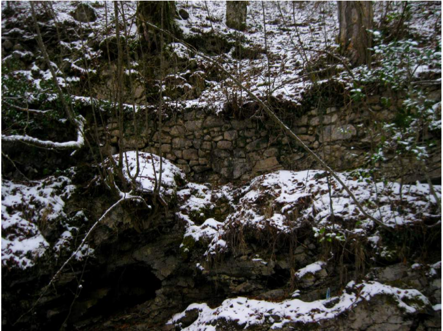
Εικόνα 65: Τυπική ξερολιθιά που υποστηρίζει το μονοπάτι μπροστά σε απότομη πλαγιά. Στην λήψη απεικονίζεται μονοπάτι στην περιοχή του ξέφωτου της μονής Αγίου Διονυσίου το οποίο σχετιζόταν με την υδροληψία της μονής και των κήπων της. Φωτογράφος: Δεληγιάννης Βασίλης
