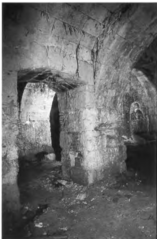
Foto 1 - Galleria sotterranea, ambiente voltato in prossimità dell'ingresso (foto G. Pani).
