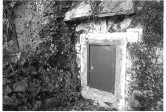
Foto 1 - Una delle prese dell'acquedotto delle "cento bocche": Accanto al portellone si nota un tratto in opus reticulatum e, sopra, uno stemma pontificio (foto C. Germani).
