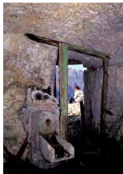
Figura 6 - CA 233 V BL - Ingresso con lavori in cemento.
