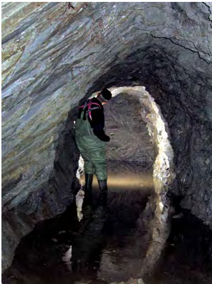
Figura 17 - Miniera bassa, parte allagata della galleria Costanza.
