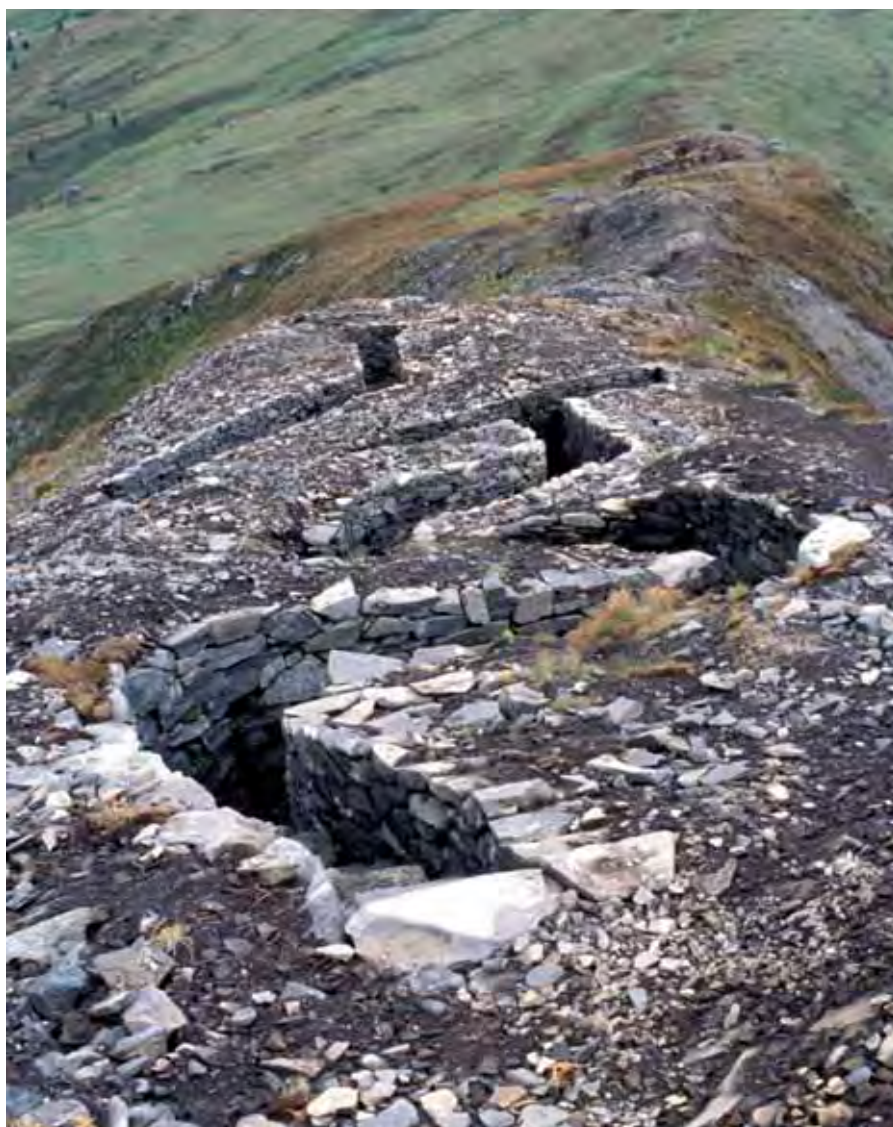
Figura 25 - Una trincea verso la sella del Sief, ripristinata nel corso dei lavori del progetto Interreg III.
