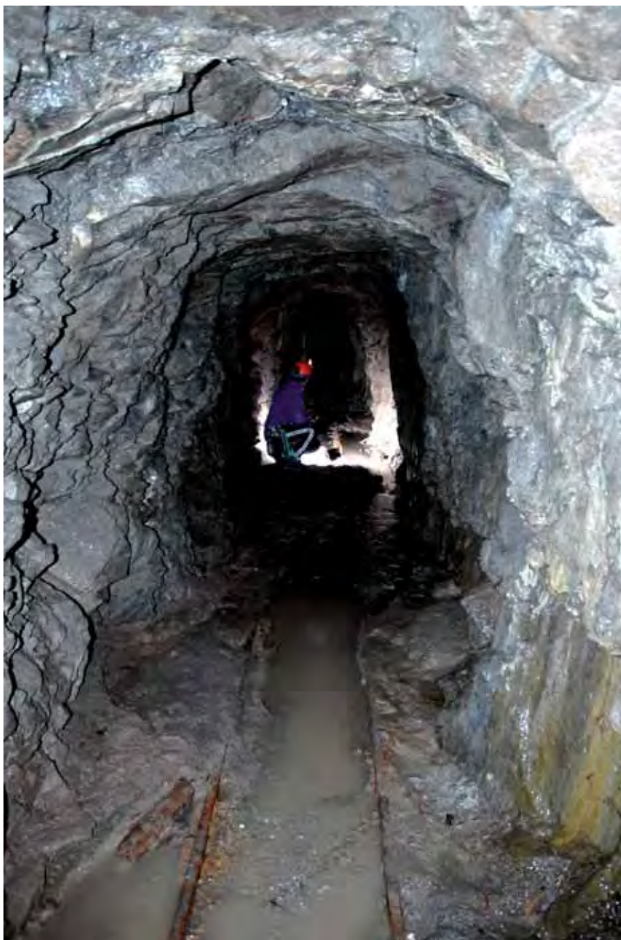
Figura 10 - Miniera bassa, vista dei binari nella galleria Costanza.
