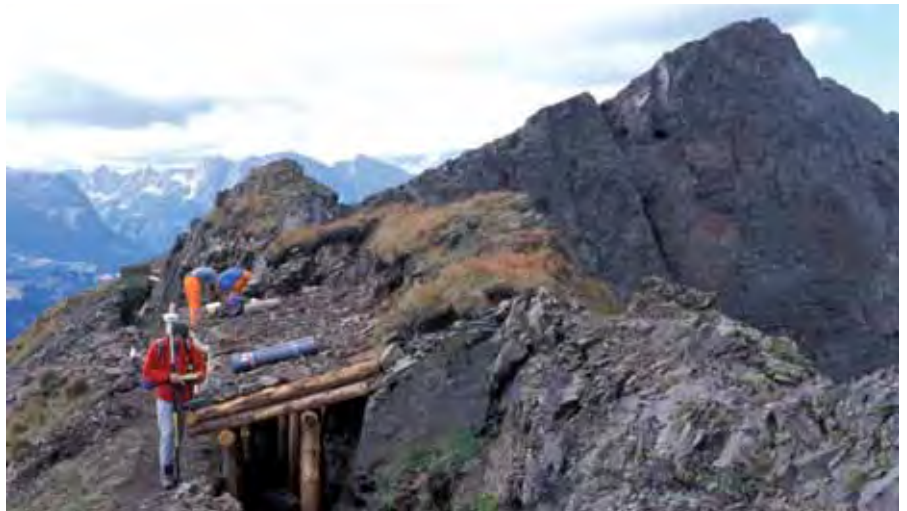
Figura 2 – Fra i vari lavori di Interreg III: ricostruzione di un tratto di camminamento coperto in cresta.
