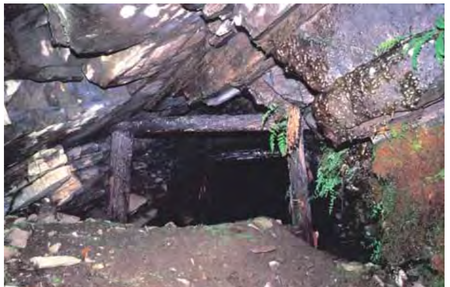
Figura 20 - Ingresso al ramo "a sinistra" della CA 243 V BL.
