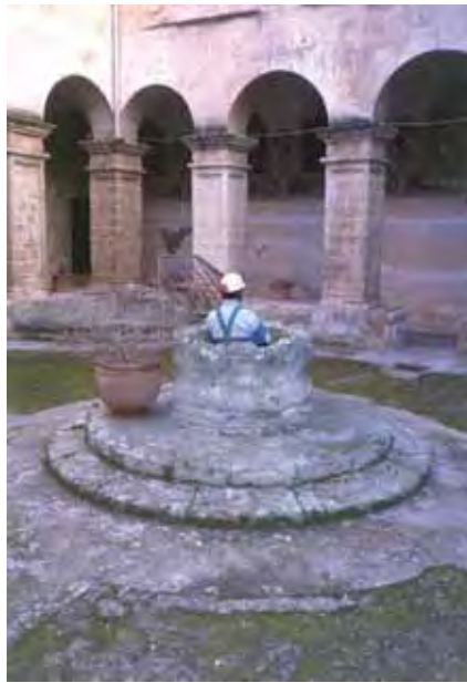
Figura 14 - Ingresso della cisterna nel chiostro del convento.
