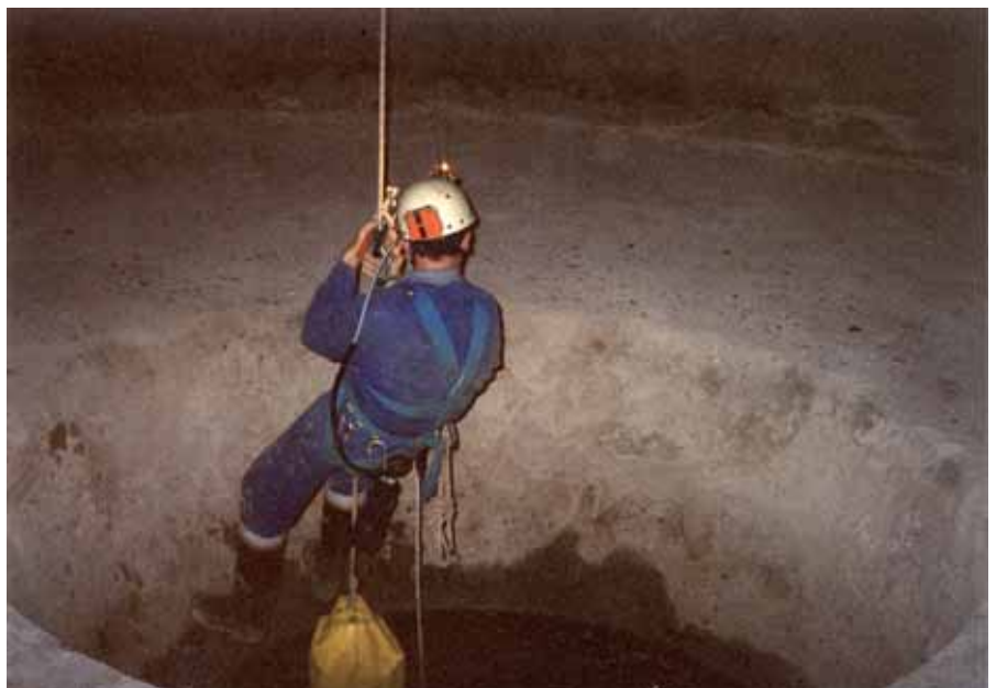
Figura 15 - Cisterna nel chiostro dei Paolotti. Cono di decantazione sul fondo.
