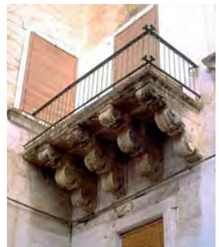
Figura 11 - Balcone in pietra con mitagliuni di sostegno.
