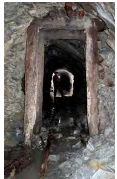
Figura 9 - Miniera bassa, travi di sostegno nella galleria Costanza.
