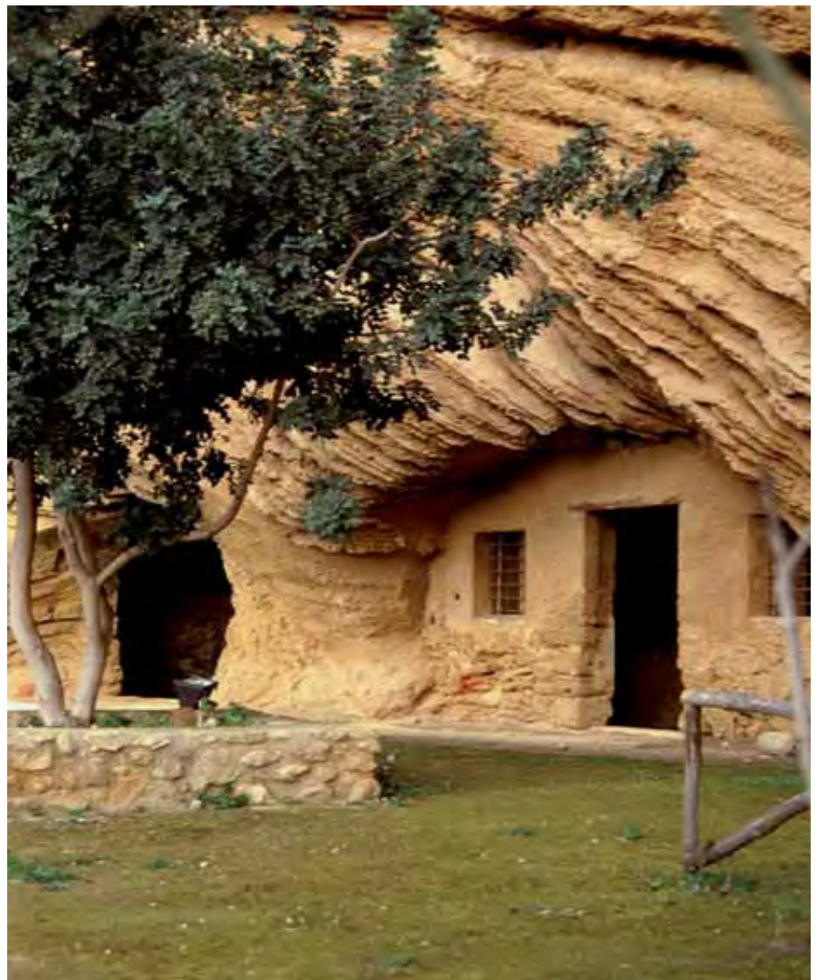
Figura 2 - Vista panoramica degli ingressi dell'"Ipogeo della stalla" e dell'"Ipogeo della torre"
