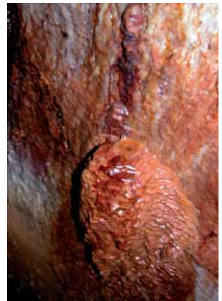
Figura 1 - Particolare di una antistalattite dell'Acquedotto Romano della Val di Setta: è evidente l'ampio foro di alimentazione e la struttura parietale a microgour.
