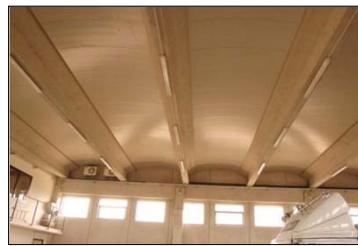
Travi in c.a.p. semplicemente appoggiate (anche su strutture gettate in opera)
