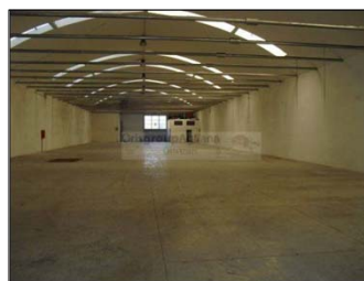
Voltine in laterizio armato con catene per eliminare le spinte
